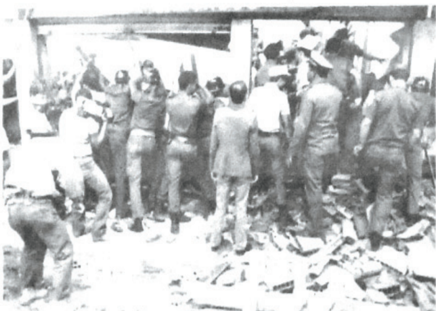
Os bombeiros precisaram sustentar uma laje para a retirada de um soterrado
