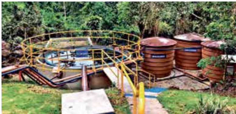
Decantador e reservatórios de água de reúso no Maanaim: água é reaproveitada para regar plantas, usar em descargas de banheiro e realizar limpeza em geral
