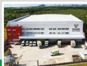
Centro de Distribuição Serra - ES
