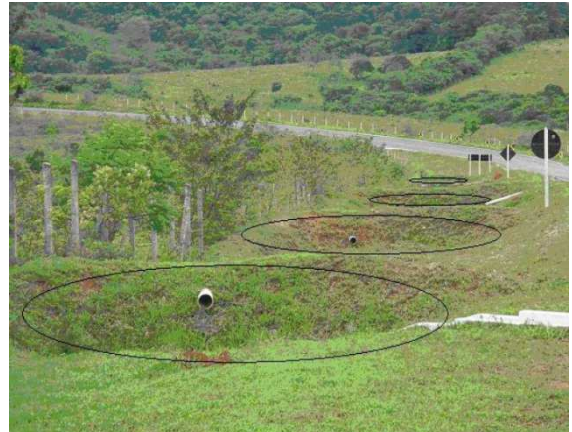
Figura 7-3: Bacias de retenção instaladas às margens de rodovia pavimentada.
