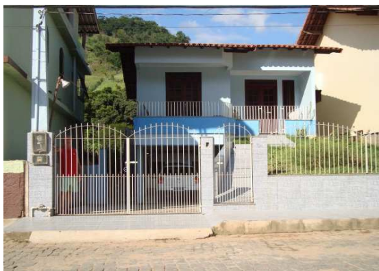
Figura 4-22: Rua Nenimato Paiva. Bacia do Córrego Santa Marta. De acordo com o depoimento do morador, a casa foi construída no segundo andar, devido a uma grande inundação.
