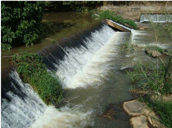
Figura 4-6: Barramento existente no rio Muqui do Sul a jusante da sede urbana do município.
