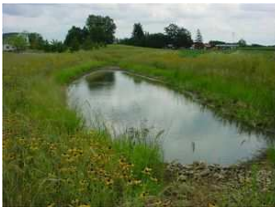
Figura 7-16: Bacia de retenção.
