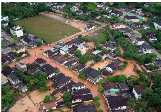
Figura 4-14: Janeiro/2005. Bairro Serrano, na bacia do Córrego da Serra.
