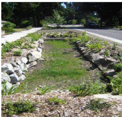
Figura 7-13: Trancheira de infiltração.
