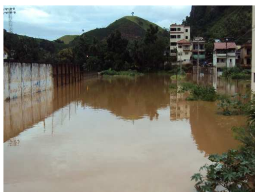
Figura 4-19: Dezembro/2010. Rua Pres. Vargas. Vista da ponte sobre o Córrego Belo Monte. Ao lado direito, estádio Cel. Paiva Gonçalves
