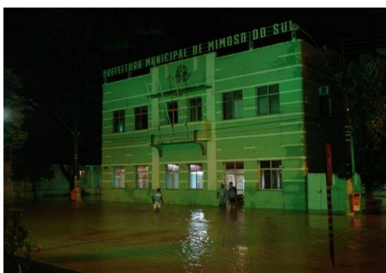
Figura 4-17: Janeiro/2007. Prefeitura Municipal de Mimoso do Sul, bairro Centro.
