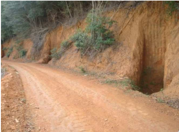
Figura 7-2: Caixas secas implantadas em estrada vicinal no município de São Roque do Canaã- ES.
