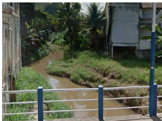
Figura 4-11: Vista da ponte sobre o córrego Belo Monte. Rua Espírito Santo.
