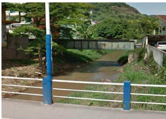
Figura 4-10: Travessia da estrada de ferro sobre o córrego Belo Monte.
