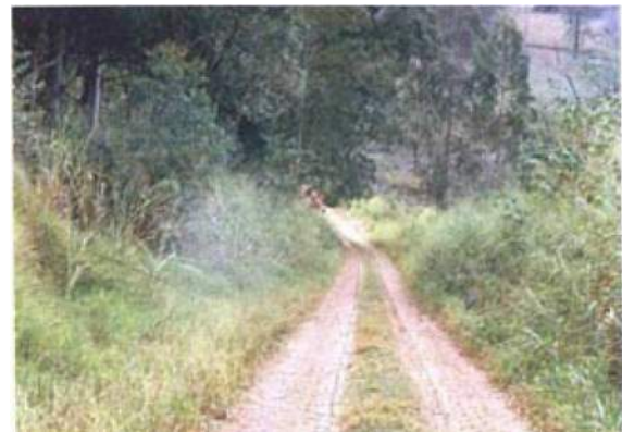
Figura 7-5: Taludes de corte e aterro e áreas não transitáveis recobertos com espécies herbáceas em estrada vicinal.
