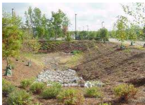
Figura 7-15: Bacia de detenção.
