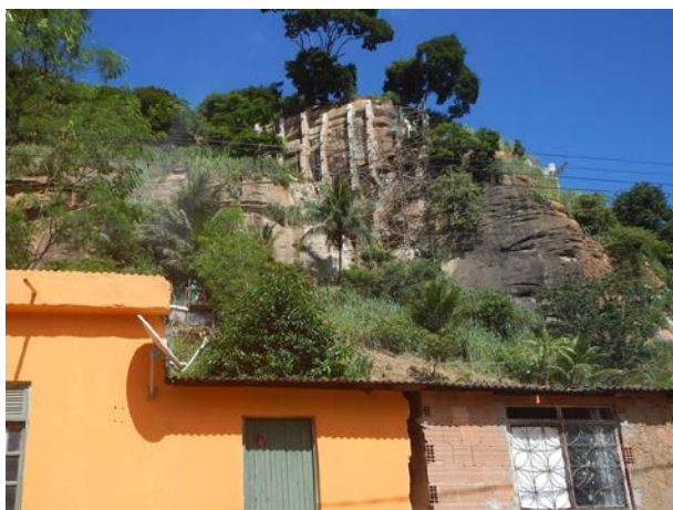
Figura 10. Vista da obra de contenção de maciço rochoso, no setor ES_MIMOSOD_SR_01_CPRM.
