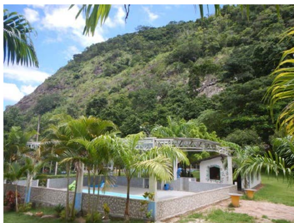
Figura 15. Vegetação densa e de grande porte, no paredão rochoso, que eventualmente pode esconder descontinuidade, blocos e lascas já delimitados na iminência de se soltarem do paredão. Setor ES_MIMOSOD_SR_03_CPRM.
