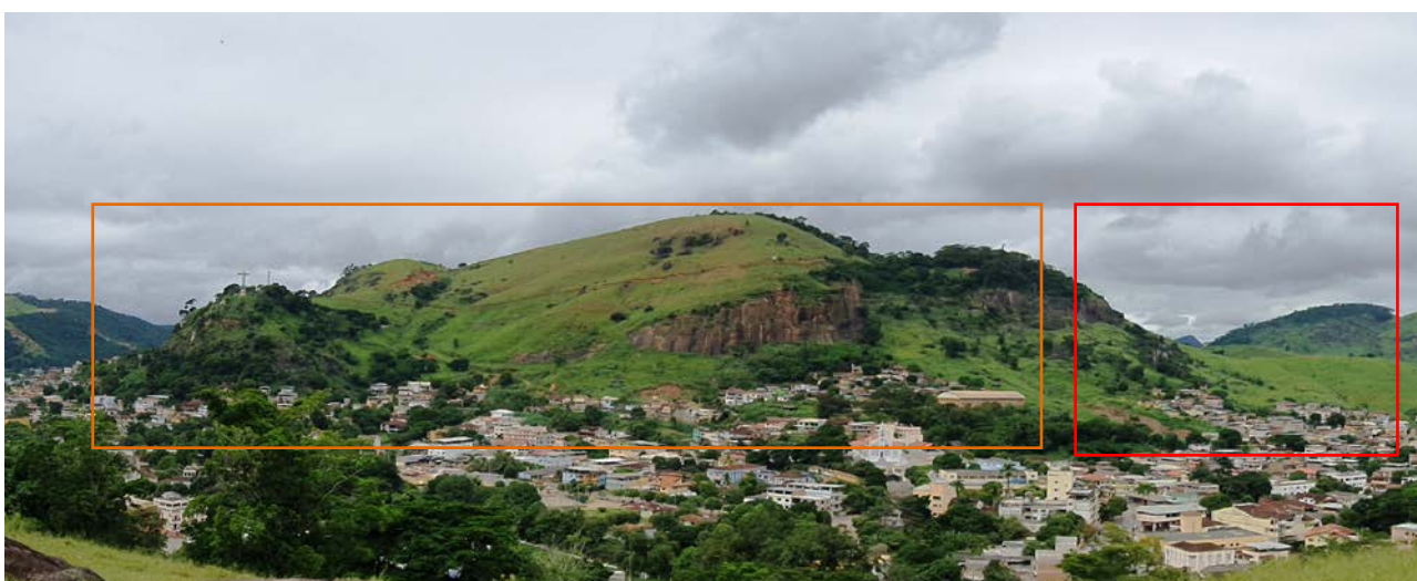
Figura 7. Vista parcial da sede do município de Mimoso do Sul, de onde pode se observar dois setores de risco geológico a queda de blocos. Da esquerda para a direita, setor ES_MIMOSOD_SR_01_CPRM (em laranja) e o setor ES_MIMOSOD_SR_16_CPRM (em vermelho).
