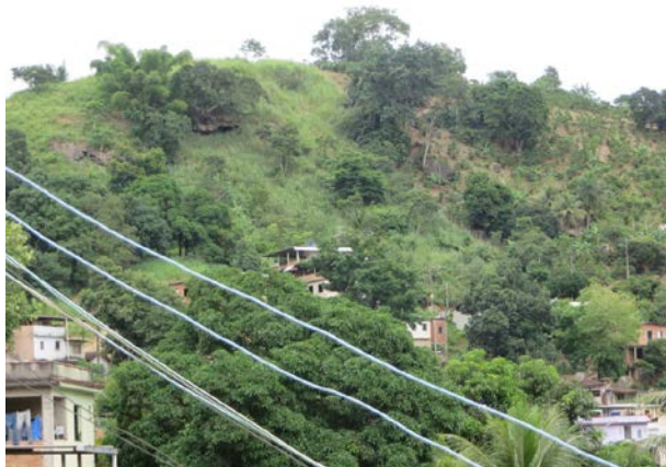
Figura 24. Blocos de rocha podendo ser mobilizados por um eventual deslizamento de solo no setor de risco ES_MIMOSOD_SR_06_CPRM.
