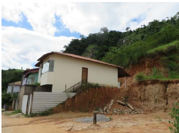
Figura 20. Talude de corte executado em encosta para construção de moradia no setor ES_MIMOSOD_SR_04_CPRM.
