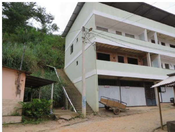
Figura 21. Encosta natural de alta declividade sendo executado corte subvertical na sua base para construção de imóveis no setor ES_MIMOSOD_SR_07_CPRM.
