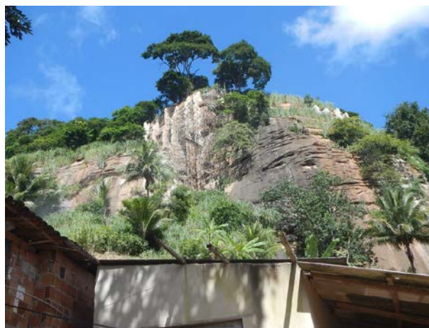
Figura 11. Vista da obra de contenção de maciço rochoso, no setor ES_MIMOSOD_SR_01_CPRM.
