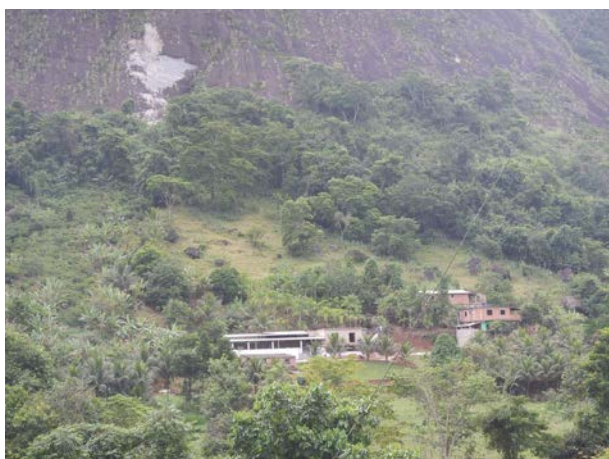
Figura 14. Vegetação densa na encosta do sopé do paredão rochoso – depósito de tálus – que podem esconder inúmeros blocos soltos com o potencial de rolamento. Setor ES_MIMOSOD_SR_03_CPRM.
