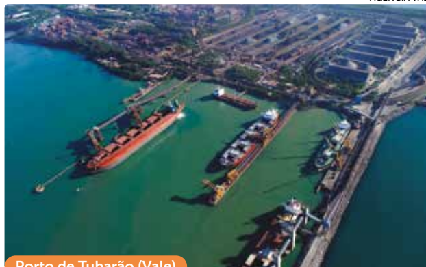
Porto de Tubarão (Vale)
