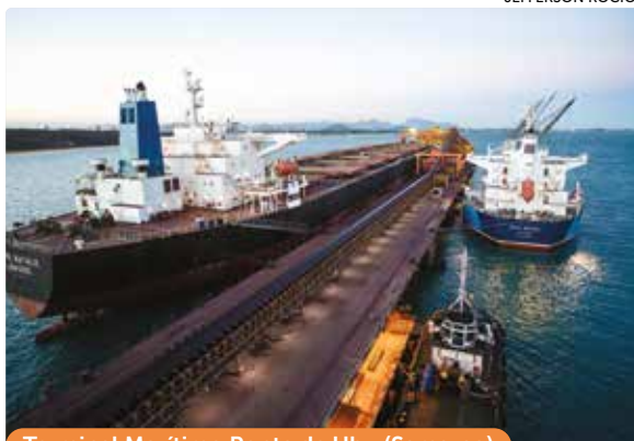
Terminal Marítimo Ponta de Ubu (Samarco)
