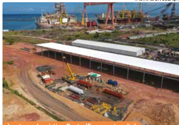
Imetame Logística Porto (Em construção)
