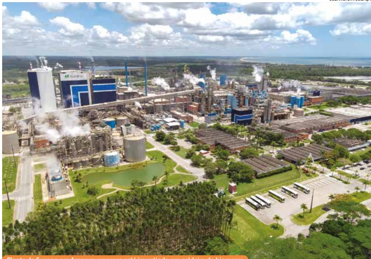
Planta da Suzano em Aracruz: empresa está investindo em caldeira de biomassa
